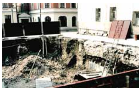
Baubeginn der Bibliothek. Foto: Archiv
