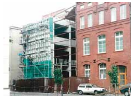
Rohbau der Bibliothek. Foto: Archiv
